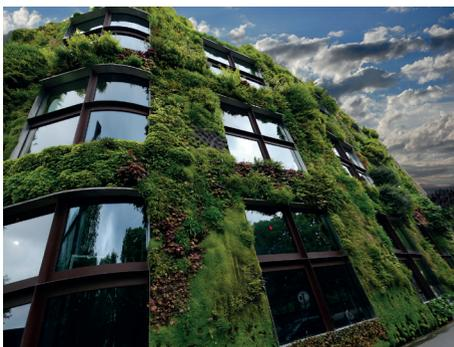
Pour lutter contre le changement climatique, une solution architecturale se développe dans nos villes : la végétalisation des façades. Le principe est simple, il s'agit d'un système de culture qui permet aux végétaux de croître sur des façades verticales.
